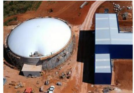
Segundo o gerente de negócios de energia da Castrolanda, Vinicius Guilherme Fritsch: "Será gerado um megawatt-hora de energia, além de 350 m<sup>3</sup>/h de biometano e 550 m<sup>3</sup>/h de biogás. Com a planta de hoje conseguiríamos suprir 100% da necessidade de CO2 da Alegria e 100% da necessidade de GLP, mas não ao mesmo tempo. Teria que reduzir a quantidade de energia gerada para 0,8 ou 0,7 megawatts, por exemplo", explica o engenheiro.
